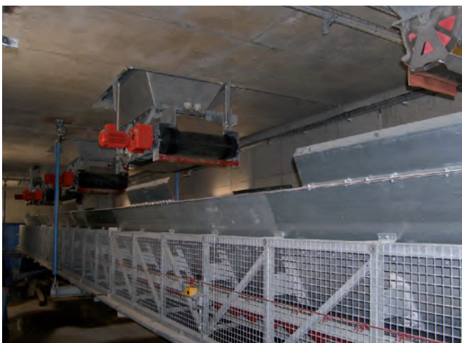
Заполнители взвешиваются на весовом дозаторе
