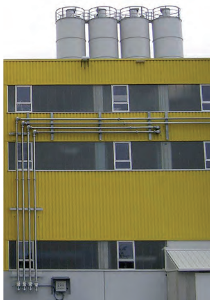
Емкость каждого из четырех силосов составляет 85 тонн
